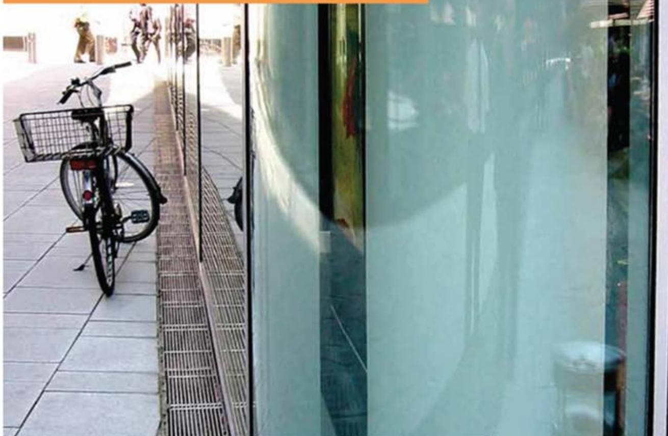
Каналы покрывают решетки. В зависимости от применения и класса нагрузки мы предлагаем следующие типы решеток: ячеистые с антискольжением, щелевые, перфорированные или плитные. Согласно действующих стандартов и норм для секций конструкции длиной более 4-х метров необходимо обеспечить соединение при помощи фланцев с прокладками. В зависимости от предпочтений заказчика стандартные каналы можно соединить с другими элементами системы водоотвода, такими как трапы и щелевые каналы.
