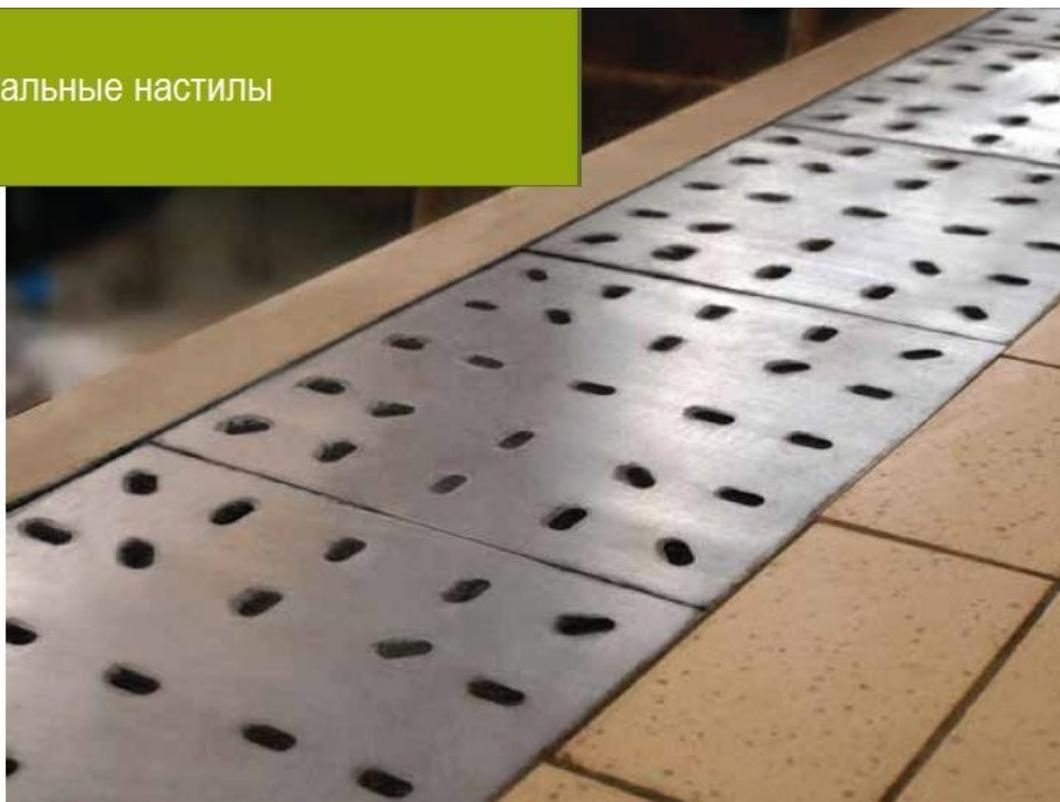
Стальные настилы компании АТТ изготавливаются из нержавеющей стали толщиной 2 мм. Они устойчивы к любым повреждениям, которые могут произойти на производстве или при использовании транспорта.
